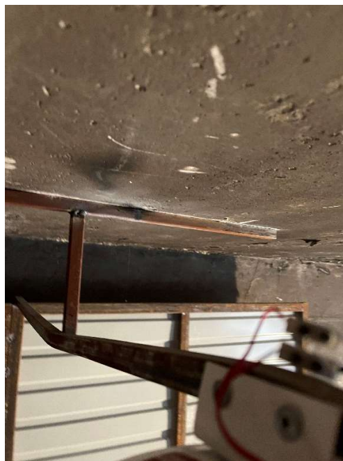
Рис. 15 Вид локального отжига металлической конструкции в месте горения огнепроводного шнура
