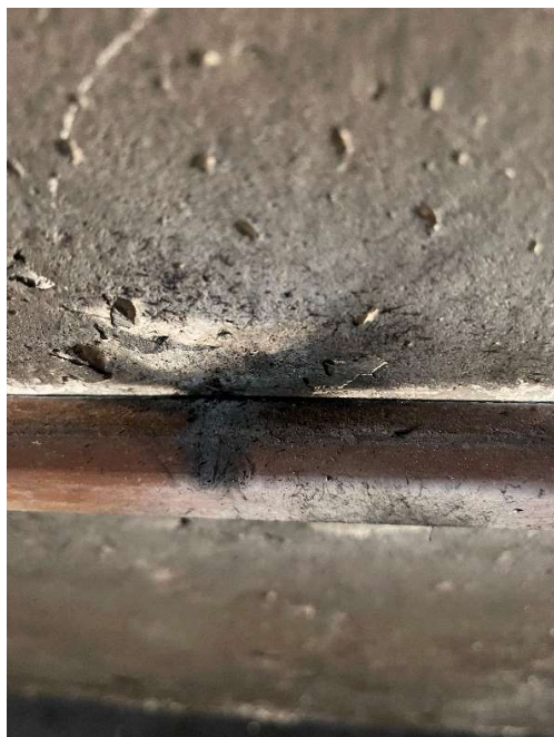
Рис. 14 Вид локального отжига металлической конструкции в месте горения огнепроводного шнура
