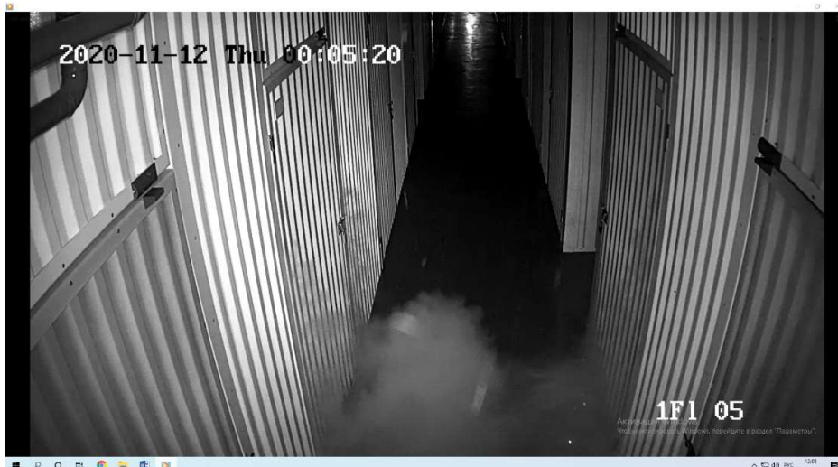
Фото 2. Вид объекта – складских ячеек до пожара. На фото зафиксирован выброс огнетушащего порошка из –под двери складской ячейки
