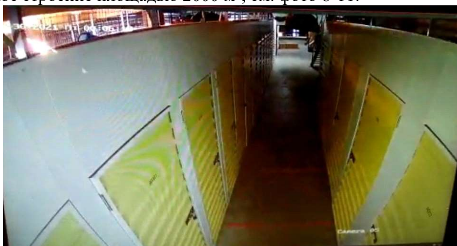
Фото 8 Вид объекта – складских ячеек до пожара. Красным овалом обозначено яркое свечение над складской ячейкой, в результате срабатывания модуля порошкового пожаротушения
