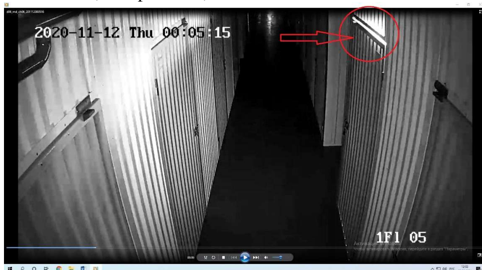
Фото 1. Вид объекта – складских ячеек до пожара. Красной стрелкой и овалом обозначено яркое свечение во внутреннем объеме ячейки хранения, в результате срабатывания модуля порошкового пожаротушения
