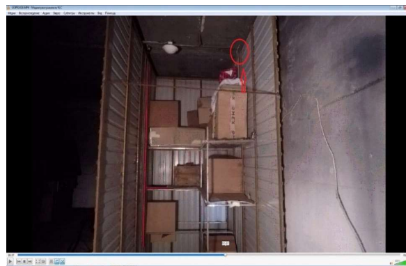
Скриншот 4. Красным овалом выделен «отстреленный» термочувствительный элемент
