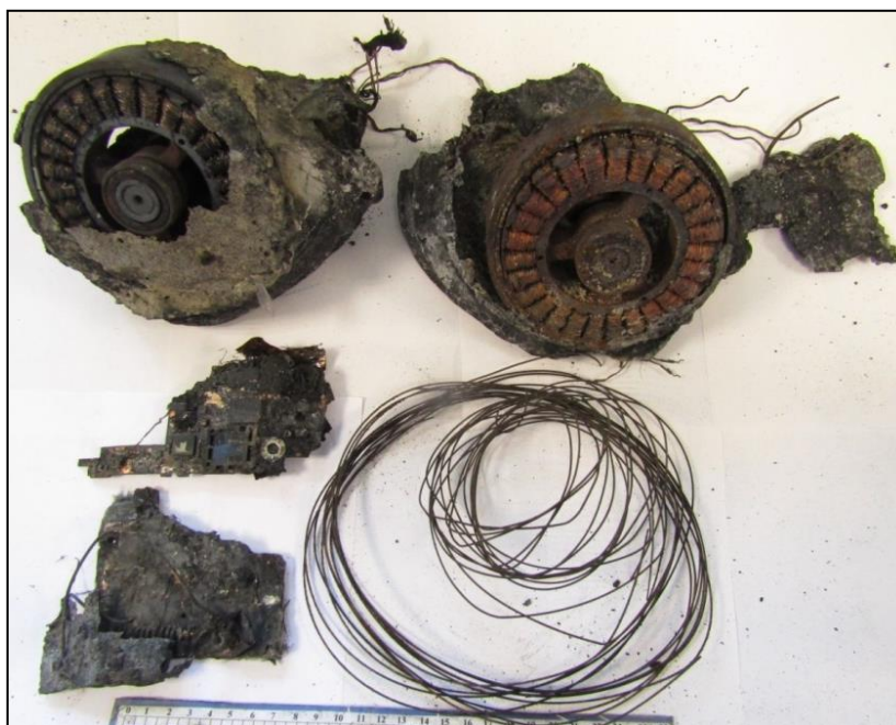
Фото 6. Общий вид представленных остатков сгоревшего трансформера.
